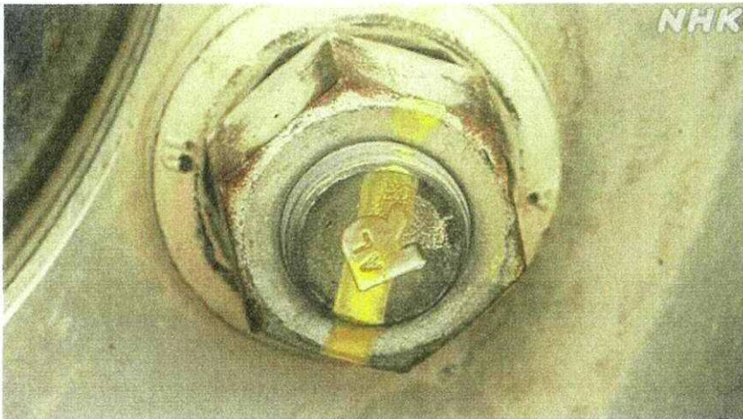
ナットとボルトに油性ペンで線
